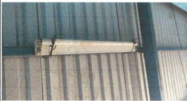
Foto 9: Sustrución de lámparas de 2x40 y sustrución de plafoneras
