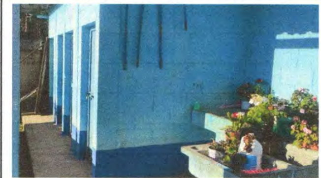
Foto 12: Instalación de lavamanos
