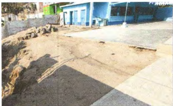
Foto 3: Reparación de piso de torta de concreto
