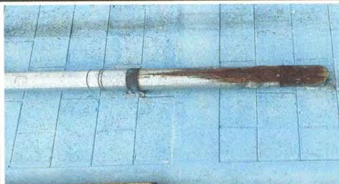
Foto 14: Sustrucción de chimenea de metal
