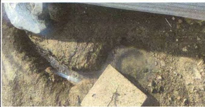
Foto 7: Sustrución de tubería PVC línea principal aguas negras.
