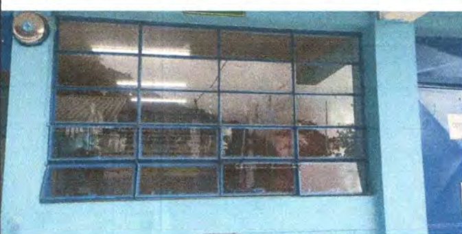
Foto 11: Fabricación e instalación de balcones de hierro en ventanas
