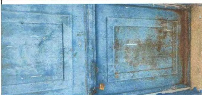
Foto1: Sustrucción de puerta
